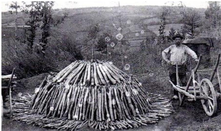
*Figure 5 : Construction d'une petite charbonnière (Source : <https://aouste-a-coeur.fr/>)*
